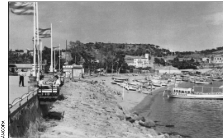
La barca Costa Brava avarada a la platja de Sant Feliu i les casetes de venda de tiquets a la barana de la platja a finals dels anys 50.
