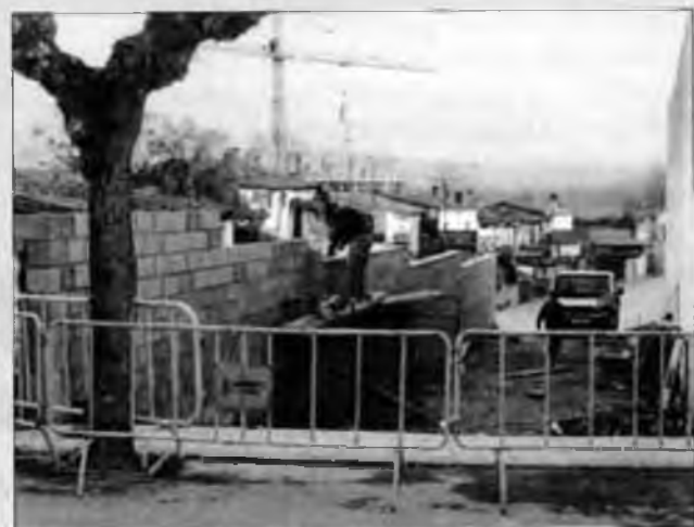
Nou vial d'accés al pavelló des del carrer Maçanet.
