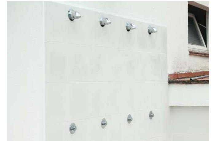
L'Ajuntament aplica millores a les instal·lacions de la piscina de Salitja
