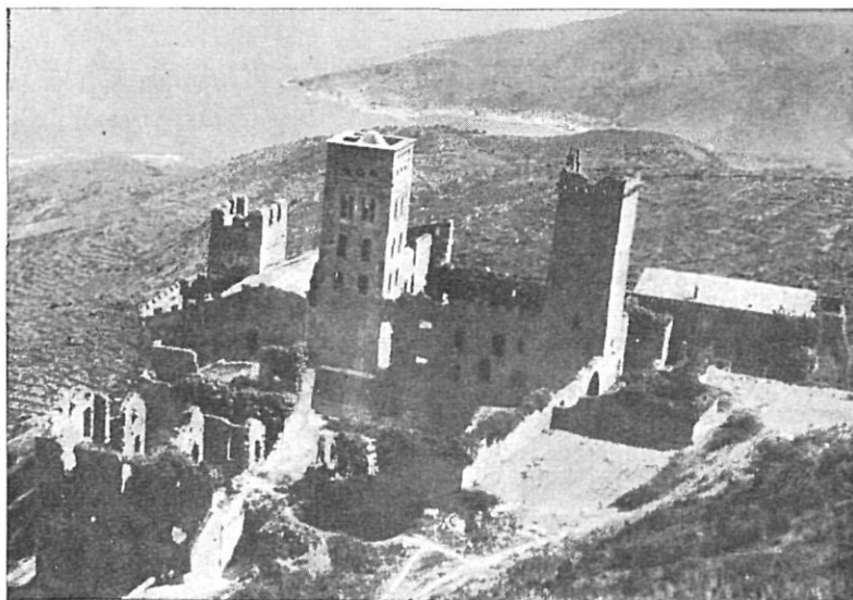
Las piedras de S. Pedro de Roda que soportaron el olvido de un siglo y la depredación ignominiosa
