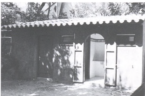
Construcció d'uns nous lavabos a la platja d'Aiguafreda.
