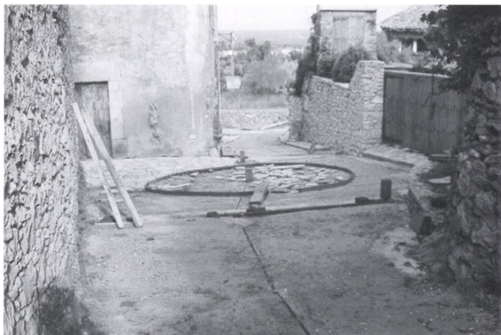
Pavimentació de la zona del nucli antic d'Esclanyà.
