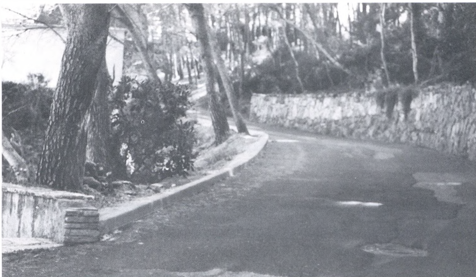
Reparació d'un tram de la carretera de Sa Riera a Sa Tuna.
