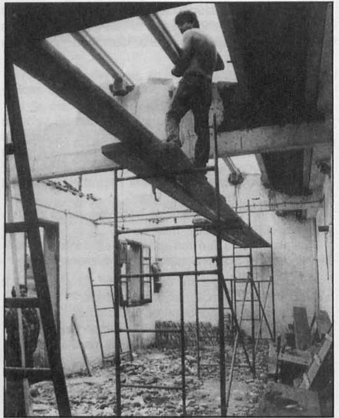
Un moment de les obres.
