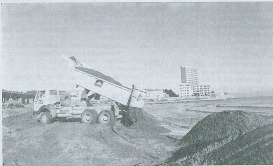
Obres de regeneració de la platja de Riells.
