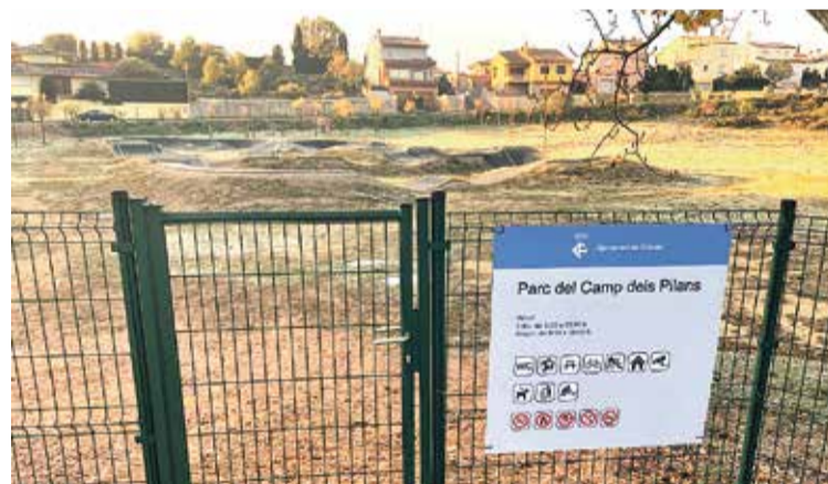
TANCAMENT PERIMETRAL. És permeable visualment i té tres portes
