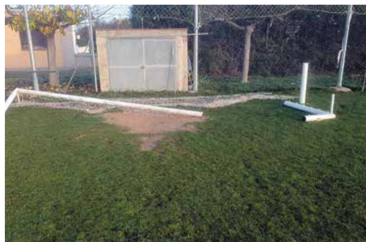
CAMP. Els vandals van malmetre les porteries del camp municipal
