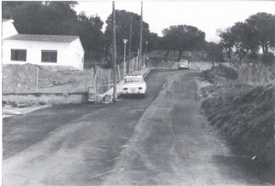
Pavimentació i urbanització del Camí de les Escoles, d'Esclanyà.
