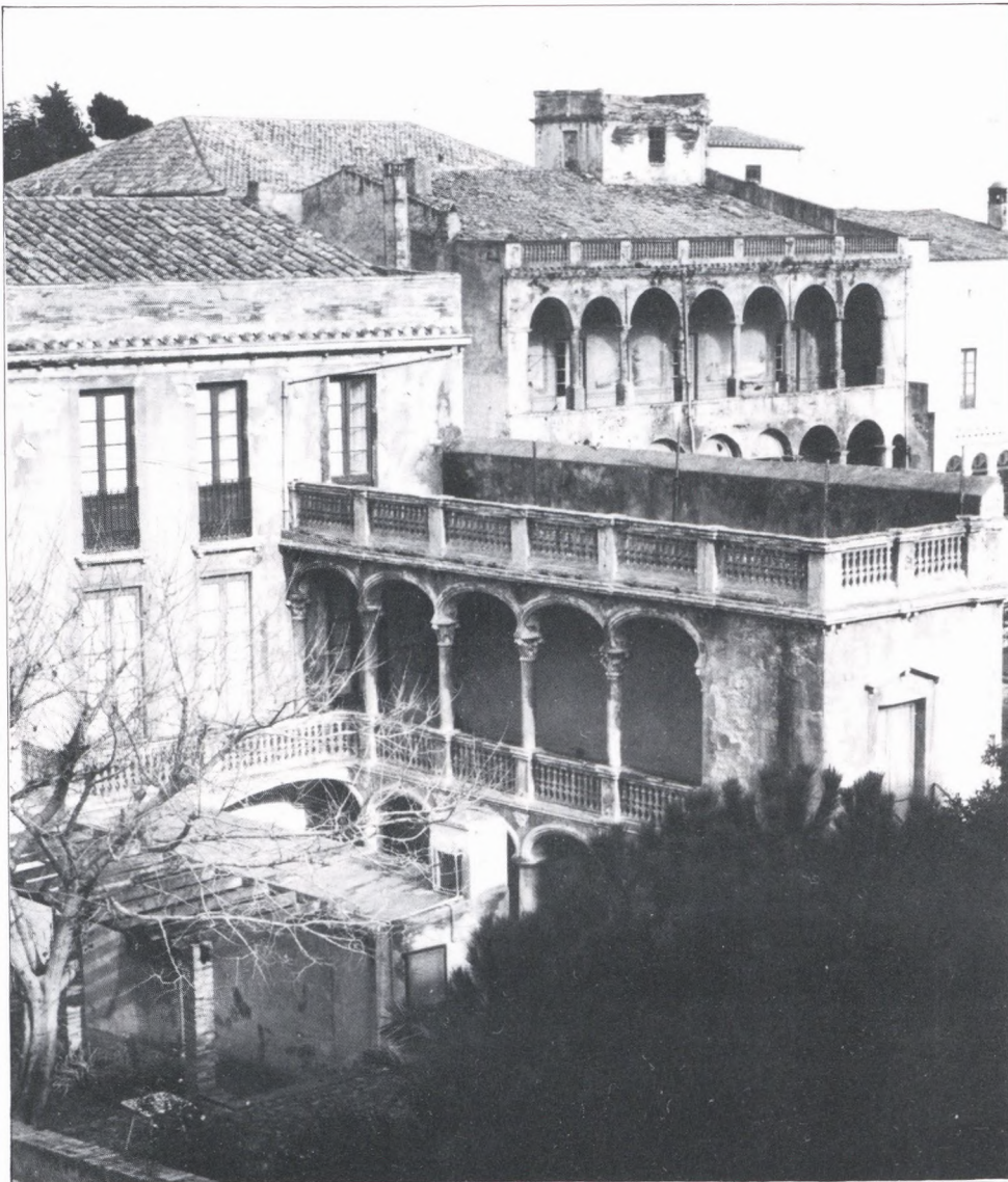
Aspecte de la casa Ferrer-Bruguera
