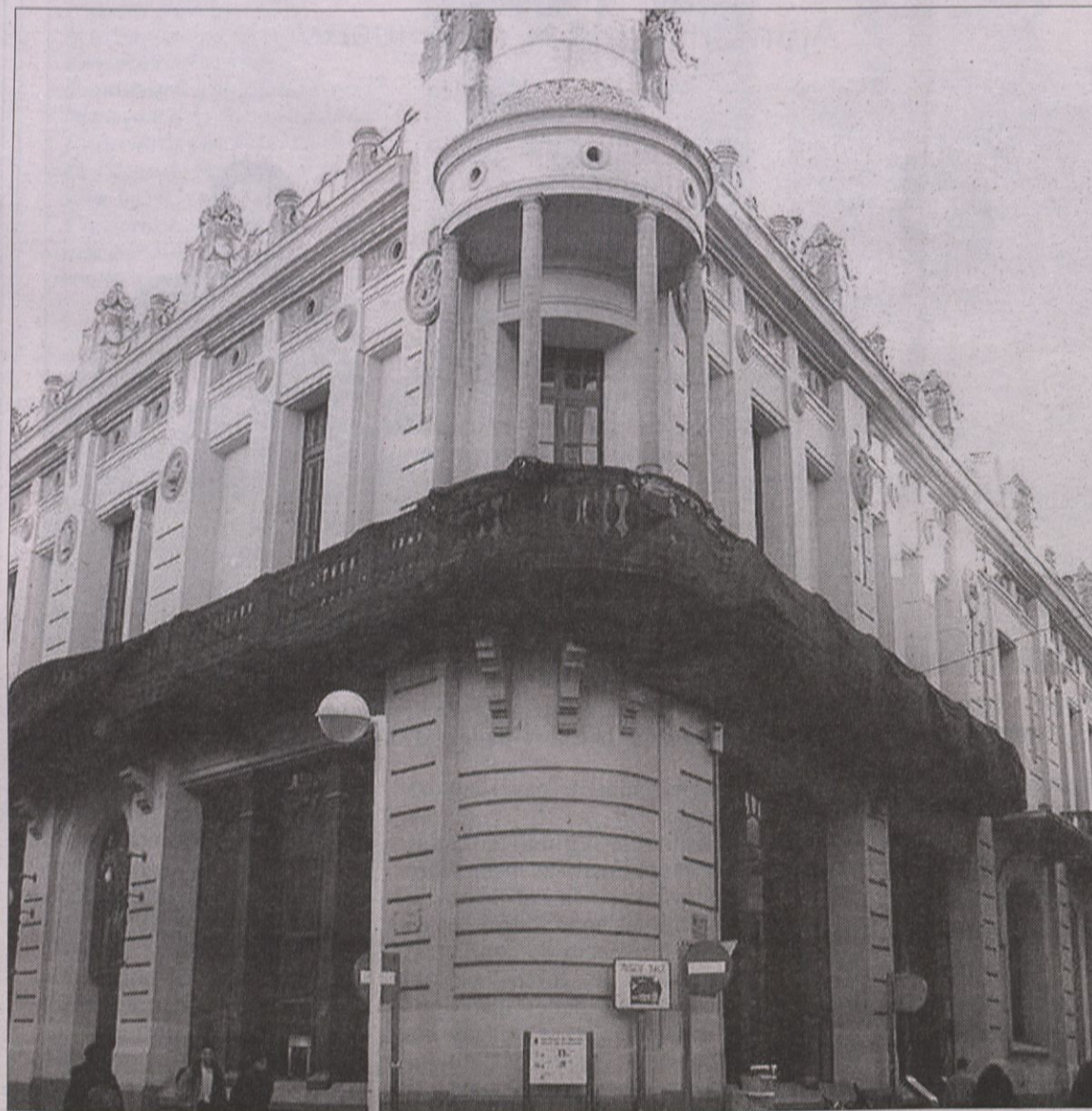
Fotografia d'arxiu, abans de començar-se les obres de remodelació. L'edifici del Casino Menestral fa anys que va començar a tenir problemes, com en el cas dels despenjaments de les cornises
