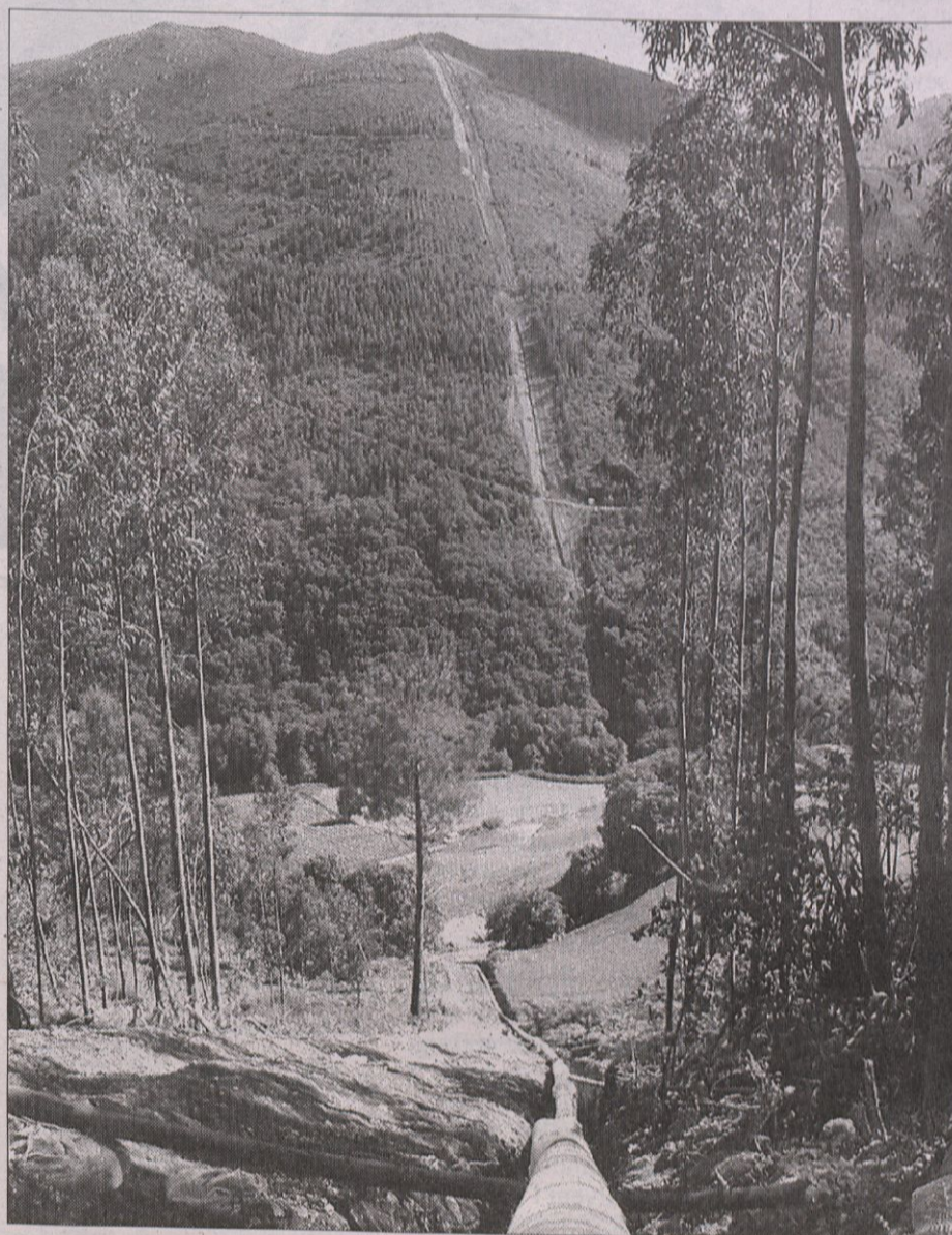
Aquest és el tram d'un gasoducte que Hidrocarbó té a Astúries
