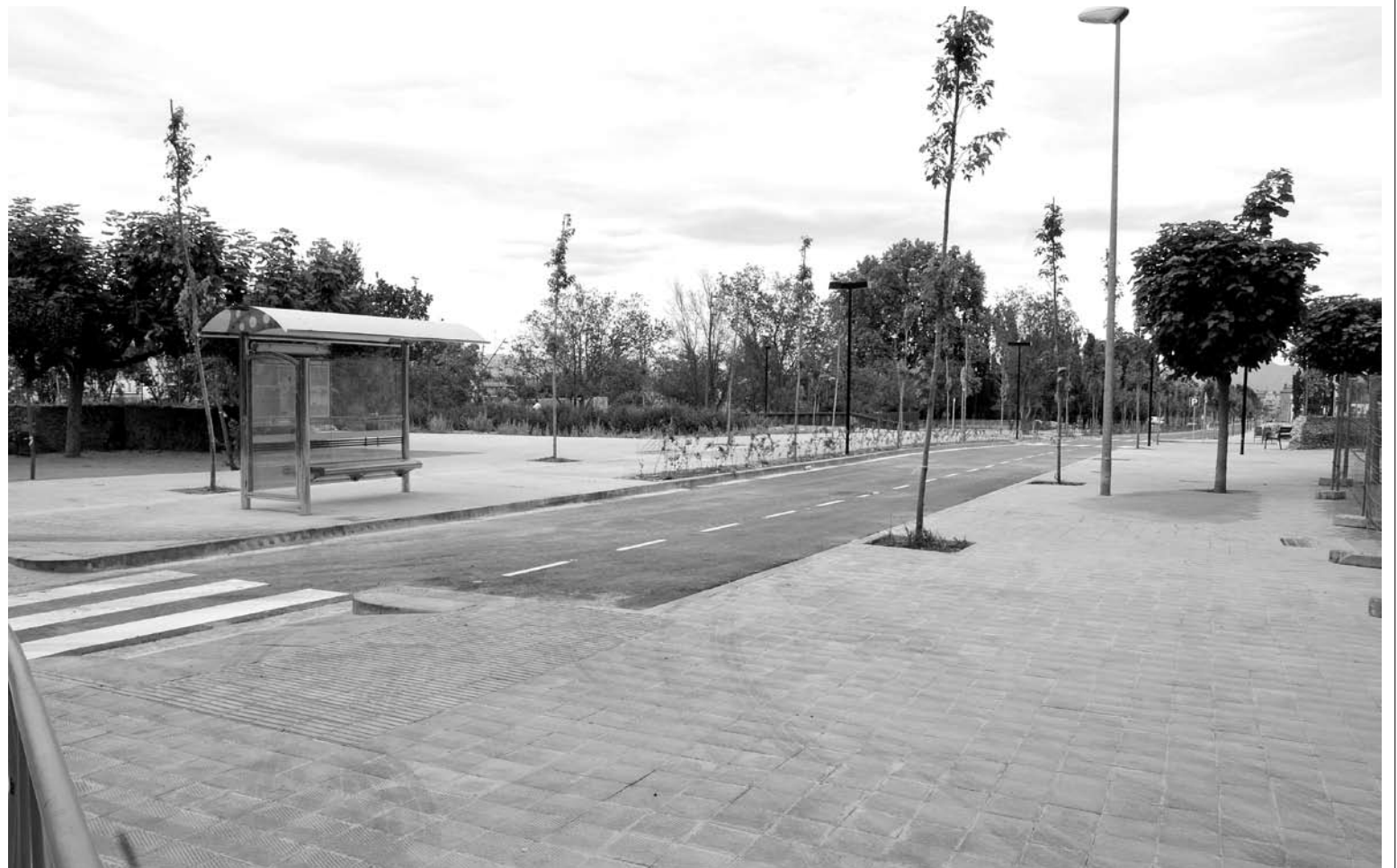
DESERT. El sector Costa Brava té quasi acabats els treballs d'urbanització, però de moment serà un barri sense veïns ni cases
