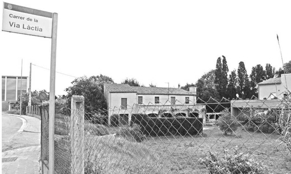
ESTACIÓ ASTRONÒMICA. L'habitatge on està situat aquest equipament quedat afectat pel projecte municipal
