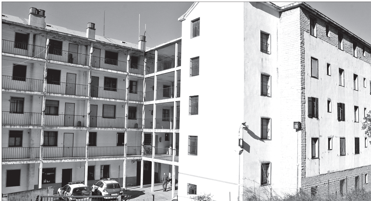
La caserna de la Jonquera encara registra activitat, però l'edifici, que està en mal estat, ha quedat massa gran per als pocs agents que hi habiten
