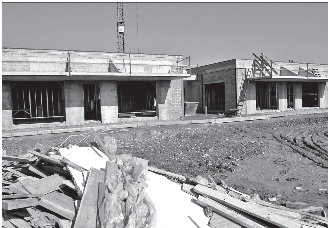
Les obres de la llar d'infants estan avançades i ja s'està escollint el mobiliari i la resta d'equipament
