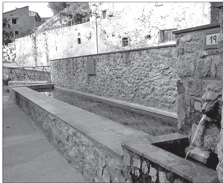
El torrent disposa d'una font al centre de Vilarnadal
