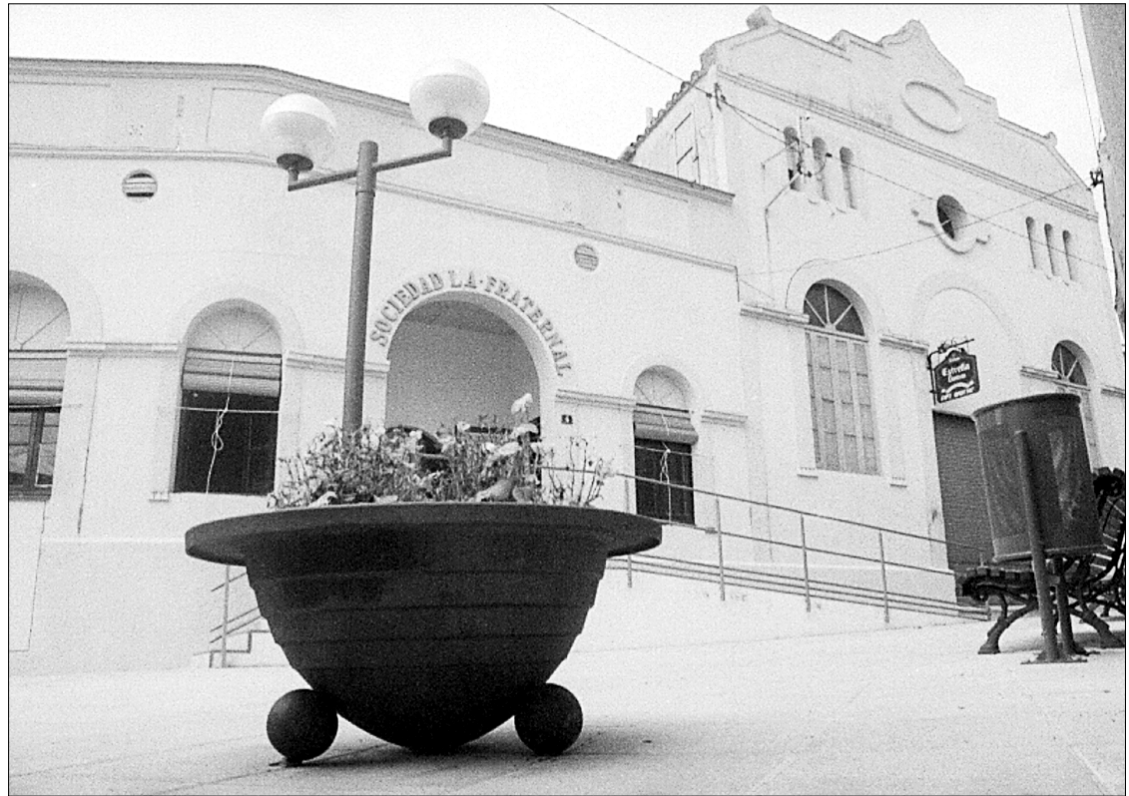
L'entrada de la societat 'La Fraternal' ja ha estat objecte d'una rehabilitació
