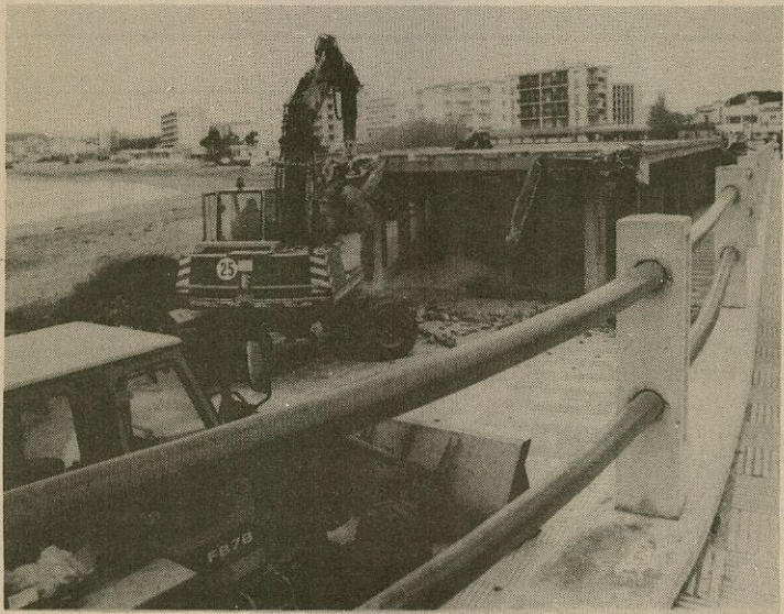
Una excavadora enderroca un dels edificis (Foto: Quim Giró)
