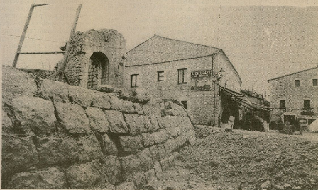
Aturades les obres a Sant Martí d'Empúries.- La comissió de Patrimoni de la Generalitat ha aturat les obres d'urbanització per estudiar quines són les alternatives que pot prendre després de localitzar diverses restes importants, com l'aparició de les muralles dels segles XIV i XV (a la foto de Quim Giró). Paral·lelament, el Departament de Cultura ha declarat el nucli de Sant Martí, Bé Cultural d'Interès Nacional, en la categoria de conjunt històric.
