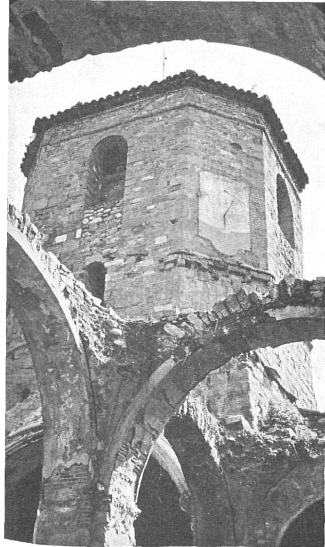
Estado al iniciarse las obras
