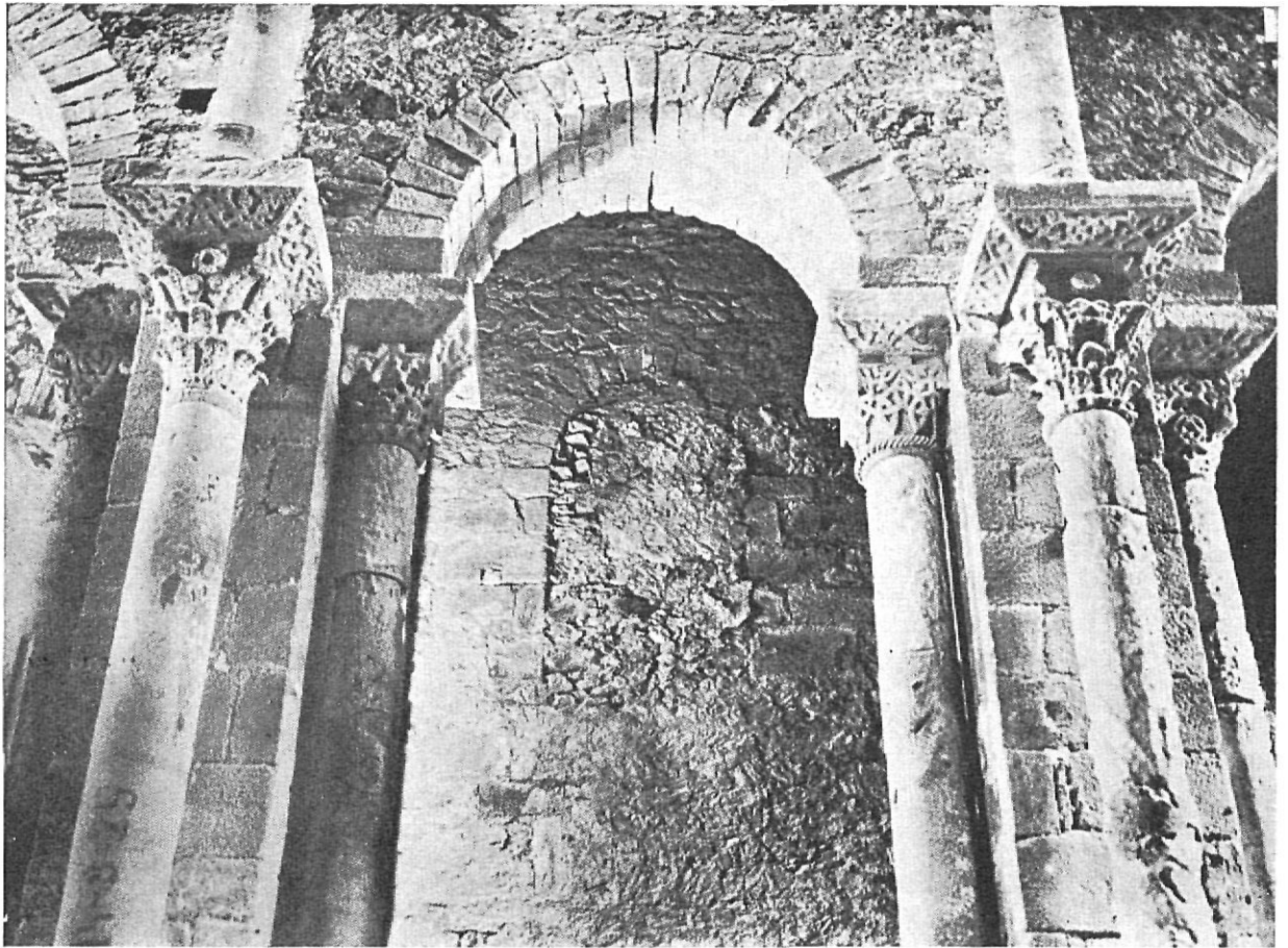
Un tramo de la nave mayor, del costado de la epístola.
