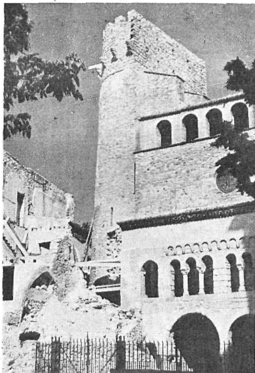
Estado de las obras al ser redactado el presente escrito.
