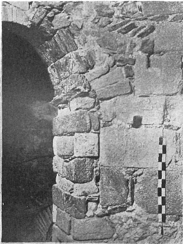
Detalle de la arquería de la girola. Se ve la jamba primitiva haciendo de un recto de muros y los arranques de los dos arcos primitivo y románico. (Fig. 15).
