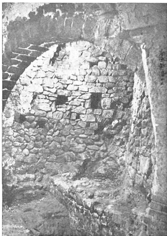
El pie de la "Torre del Fum" —a la derecha— descansando sobre un muro antiquísimo.
