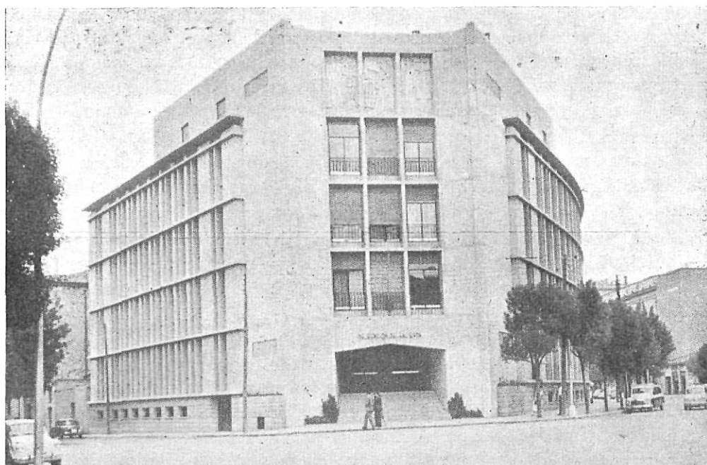
Nuevo edificio de la Delegación de Hacienda.
