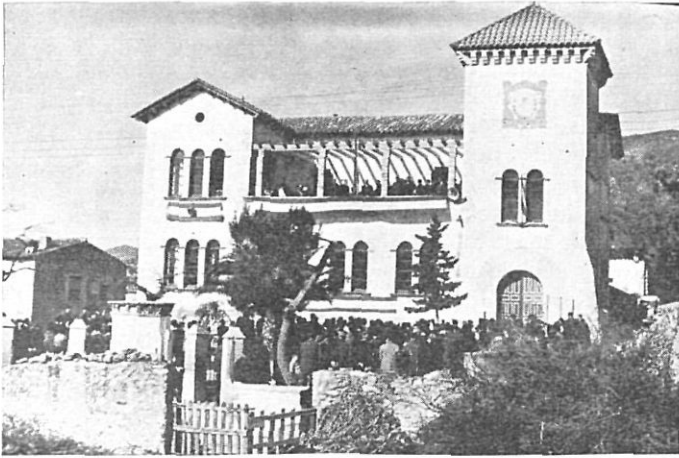
Restauración Escuelas de Palau Sabardera
