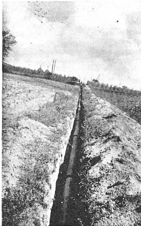
Detalle de las obras
