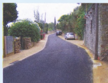
Pavimentació i serveis al carrer del Bany de la Sultana
