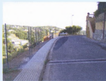
Consolidació de la vorera al carrer de la Xarmada
