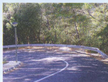
Millores en seguretat a la carretera de la platja del Racó
