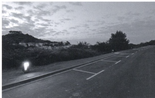
Nova vorera i enllumenat del Camí del Mar, des del pàrquing de Ribelino's fins a la cruïlla de Sa Tuna
