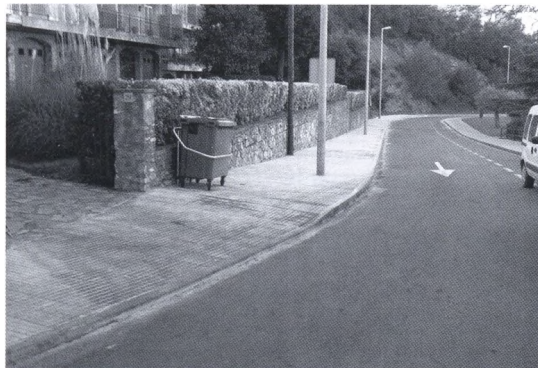
Renovació d'una part de la vorera de l'avinguda Onze de Setembre.
