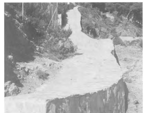
3: Remodelació del camí de ronda de Sa Riera a l'Illa Roja. Obra realitzada pel Ministeri de Medi Ambient.
