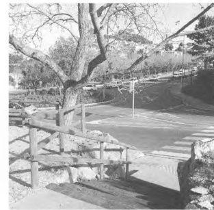
Pavimentació pàrquing cementiri.
