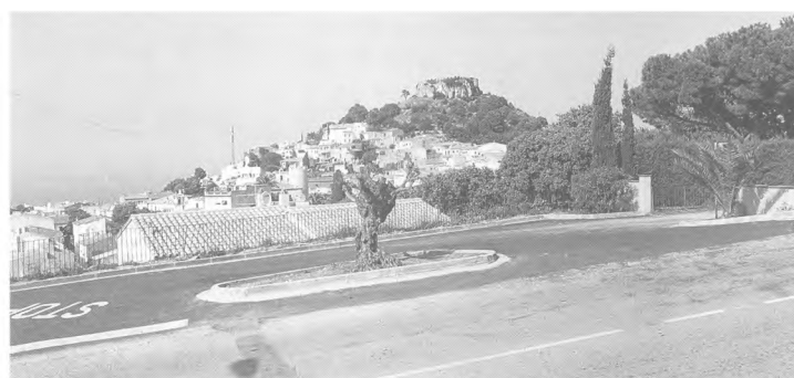
Arranjament Mirador de Begur de la carretera de circumval·lació
