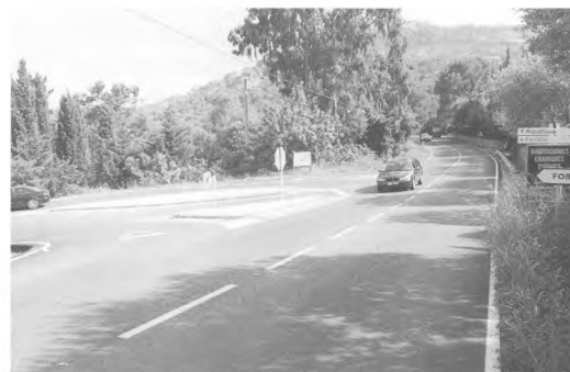
Millores de la carretera d'Aiguablava i la cruïlla de Fornells (Diputació de Girona)
