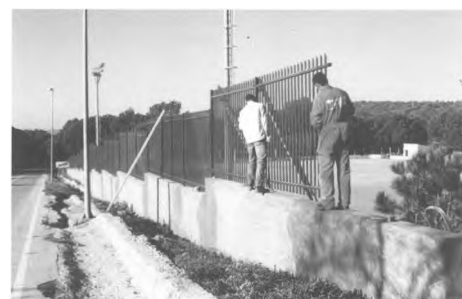
Nou tancat al camp de futbol.
