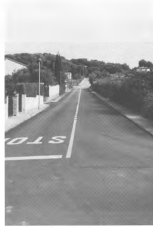
Asfaltatge d'urbanitzacions per valor de 60.000.000 de pessetes.
