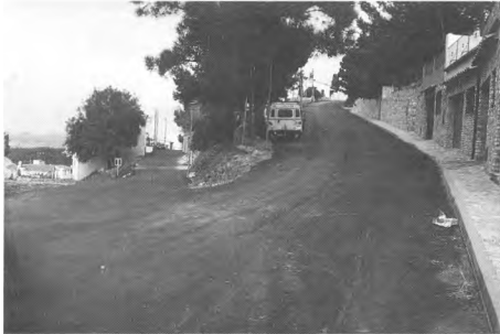
Asfaltatge de carrers a la zona de Son Pujol.
