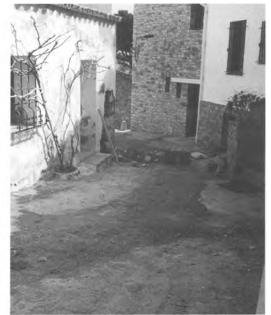
Pavimentació a la zona de Fornells i soterrament de les conduccions elèctriques i telefòniques.
