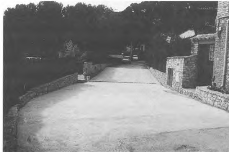
Cala del Rei. Pavimentació de carrers i recollida d'aigües pluvials.
