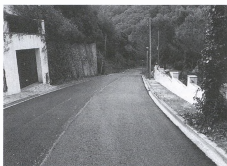
Asfaltatge de la urbanització de La Borna.
