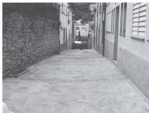
Pavimentació del carrer de Sant Gaietà.
