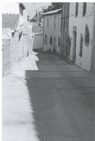
Pavimentació del carrer de Son Pujol.
