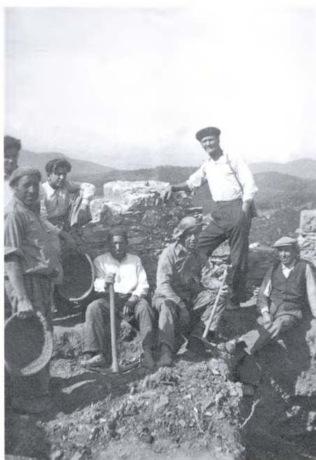
Les excavacions al Castell de Begur del 1945.
