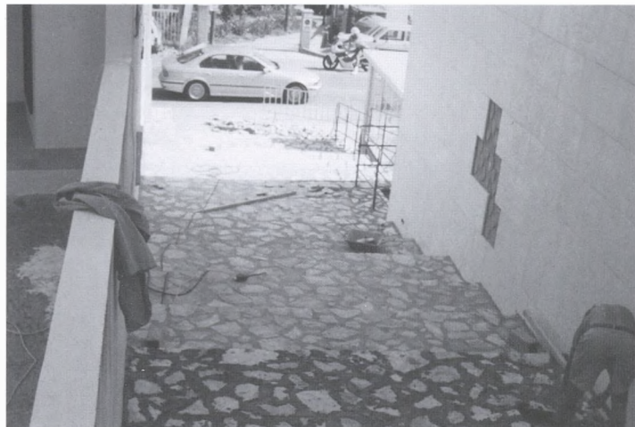
Condicionament del passadís del carrer Lluís Miró.
