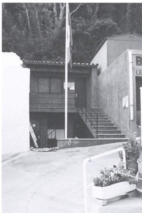
Construcció d'uns nous lavabos a la platja d'Aiguablava.
