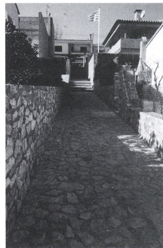
Condicionament del carrer de Sa Fontansa.
