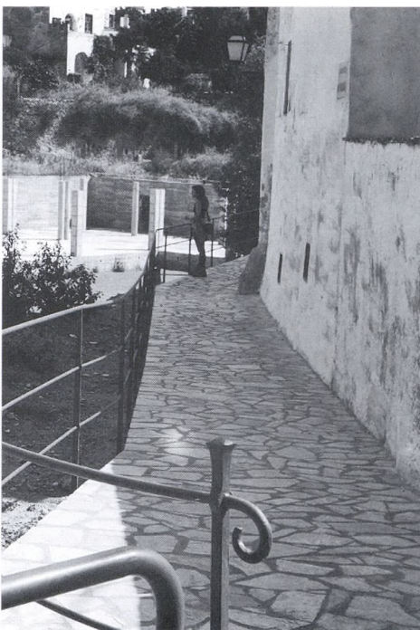
Remodelació del carrer Font de Baix.
