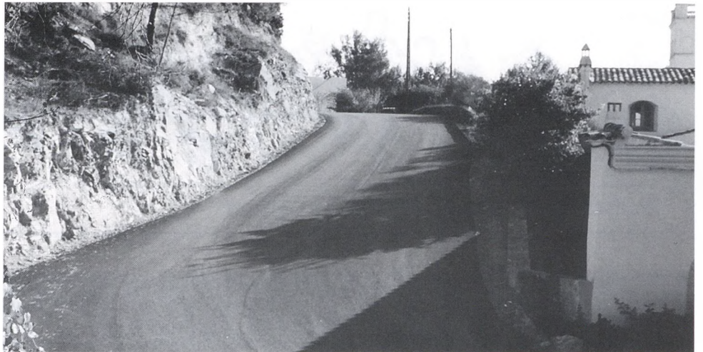
Eliminació del coll d'ampolla de la carretera del Convent de Santa Reparada, direcció al Mas Mató.
