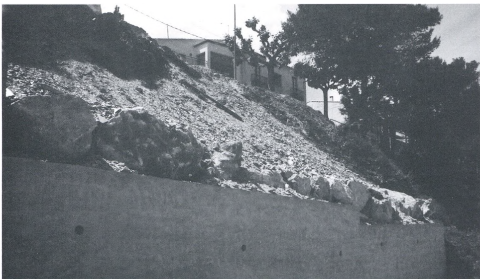
Mur de contenció marge Font de Baix.
