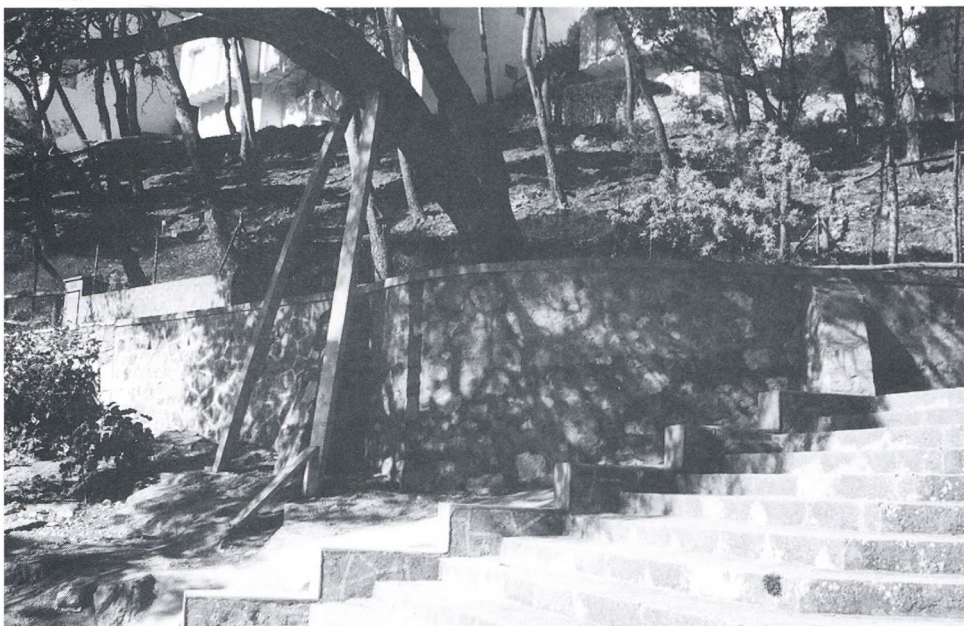
Arranjament mur terrassa cala d'Aiguafreda.
