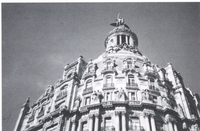
Part superior de l'edifici de la "Unión y el Fénix" Barcelona (1927)
