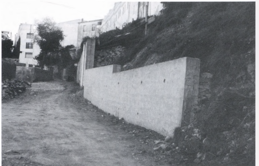
Mur de contenció a la Font de Baix (subvencionat per la Diputació).
