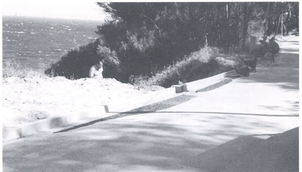
S'ha reparat la carretera d'Es Port des Pi, a Sa Riera.
