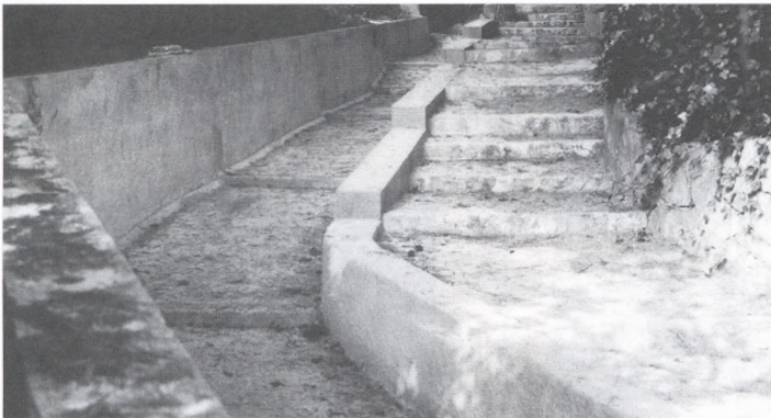
Treballs de separació de la riera i el camí de Ronda de Cap Rubí, realitzats conjuntament amb la comunitat de propietaris Es Cau. (Desembre 1992)
