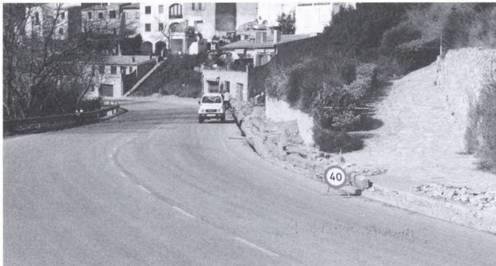
Les obres d'il·luminació i de construcció de voreres de la carretera de circumval·lació avancen a bon ritme. (Juny 1993)
