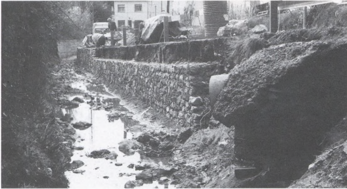
A Esclanyà s'està construint un mur que protegirà la vorera de la Font Gran fins al pont Codina. (Desembre 1991)
