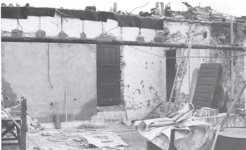
S'han reiniciat les obres dels pisos de l'Hospital de Sant Carles.
