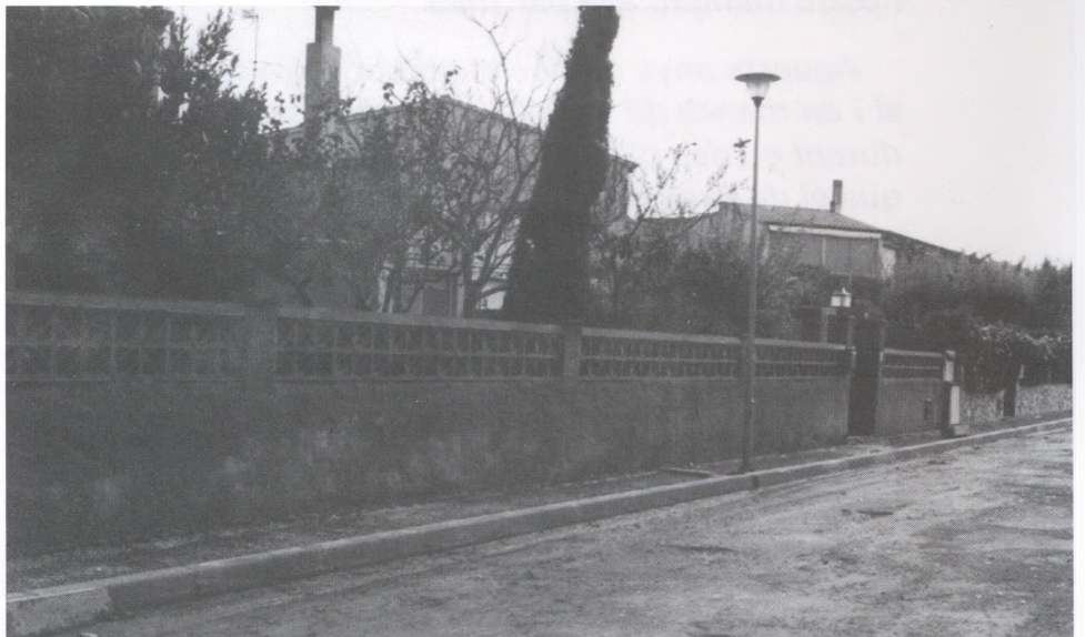
S'ha reparat la vorera del carrer Cardina, a la font Martina.
