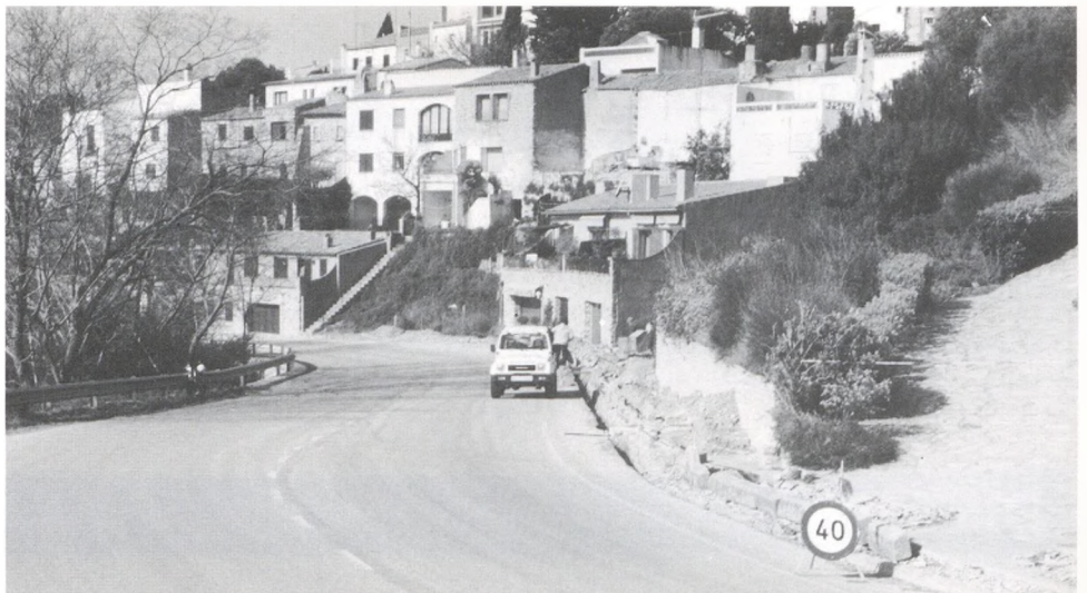
Les obres d'il·luminació i de construcció de voreres de la carretera de circumval·lació avancen a bon ritme.
