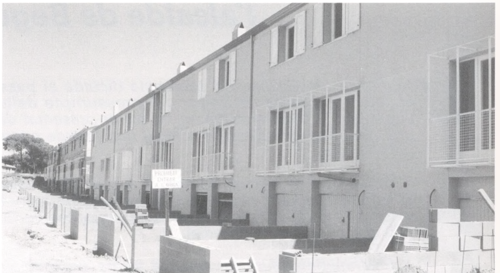
Les obres de construcció dels habitatges de la segona promoció de Bemusea s'acabaran dins els terminis previstos.
