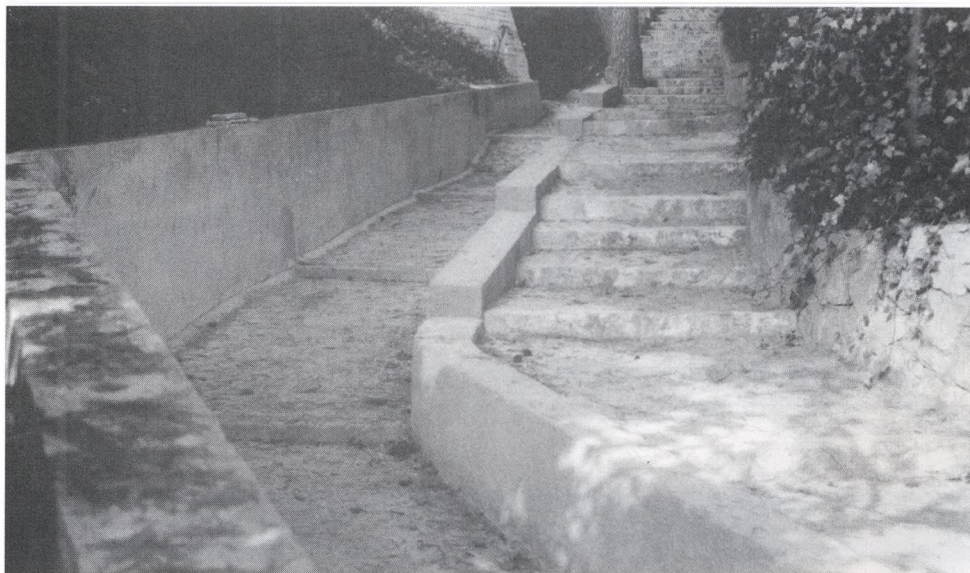
Treballs de separació de la riera i el camí de Ronda de Cap Rubí, realitzats conjuntament amb la comunitat de propietaris Es cau.
