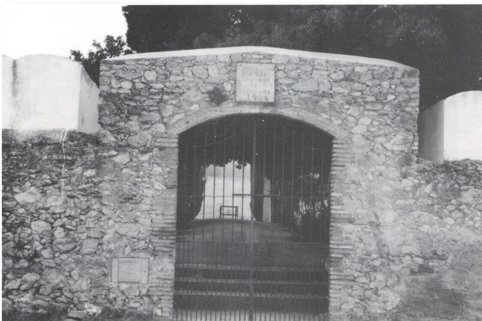
S'han efectuat les obres de restauració del cementiri d'Esclanyà.
