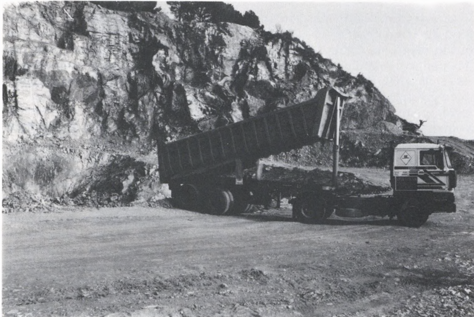
S'han iniciat les tasques de restauració de la pedrera.
