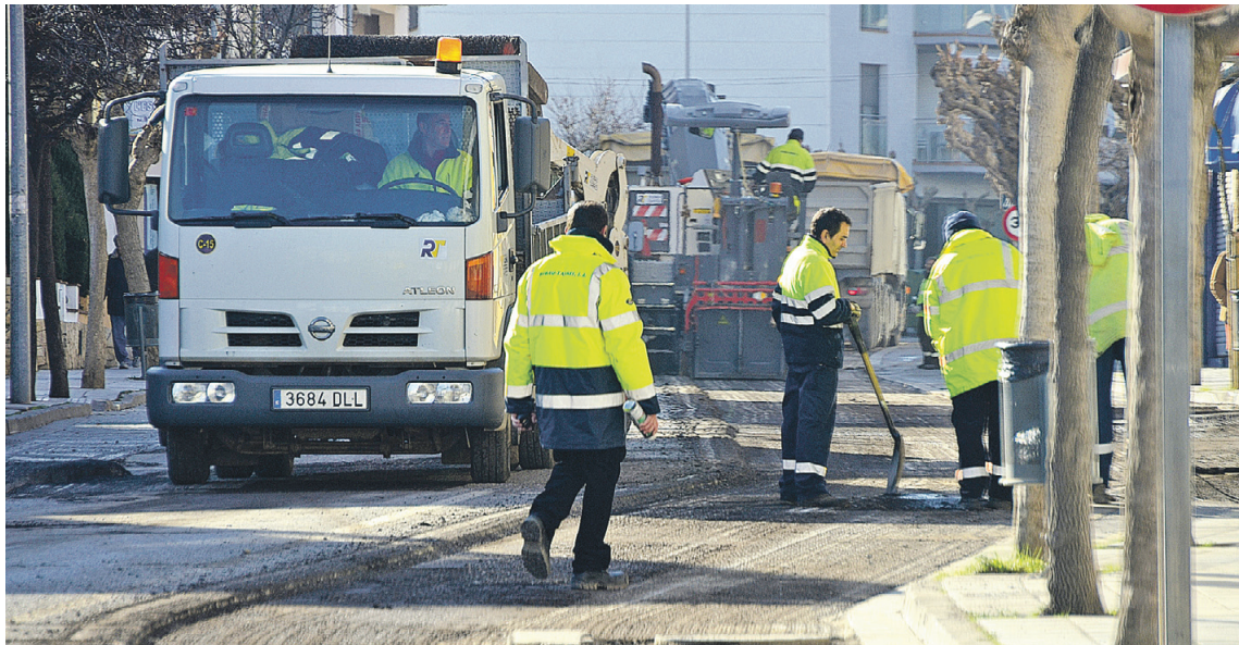
MÀQUINES EN MARXA. Ahir van començar els treballs a l'avinguda Girona
