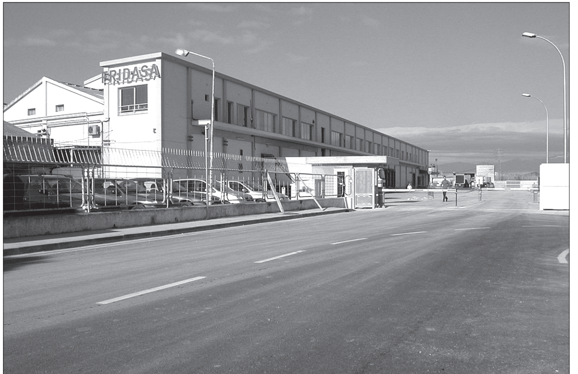
Les actuals instal·lacions de l'escorxadador de Fridasa, al barri de la Marca de l'Ham de Figueres
