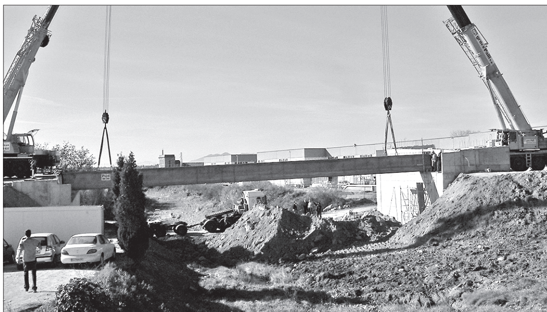
Dimarts passat es van començar a col·locar les bigues del nou pont
